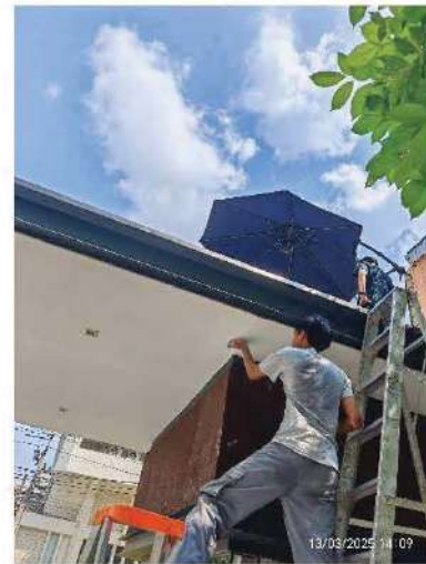
เจ้าหน้าที่ฝ่ายช่างตรวจสอบ และอุดรอบรั้วผนัง ผ้าเพดาน
