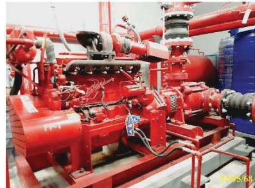
ถังเก็บน้ำดับเพลิงใต้ดิน พร้อมเครื่องสูบน้ำดับเพลิง
