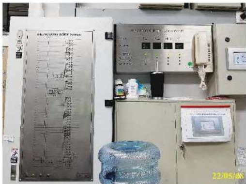
แผงควบคุม (Fire Alarm Control Panel : FACP)
