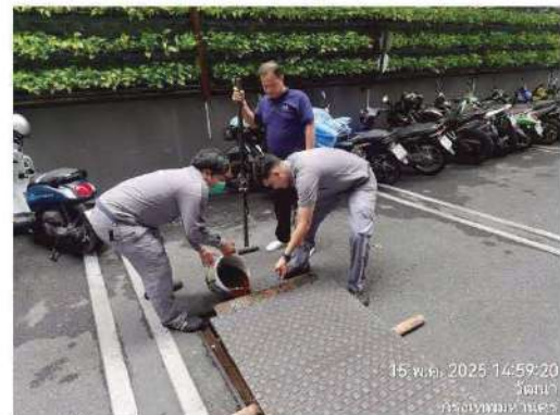
เติมจุลินทรีย์ระบบบำบัดน้ำเสีย
