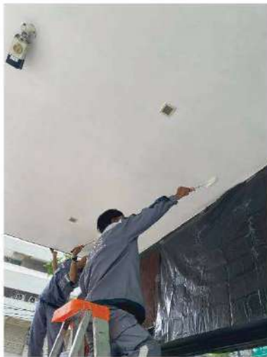
เจ้าหน้าที่ฝ่ายช่างตรวจสอบ และอุดรอบรั้วผนัง ผ้าเพดาน
