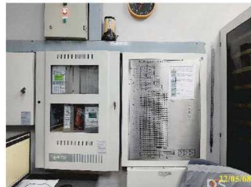
แผงควบคุม (Fire Alarm Control Panel : FACP)
